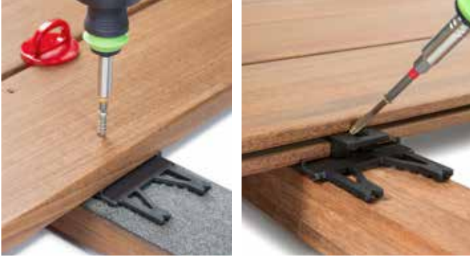
Pose des lames par vissage apparent
